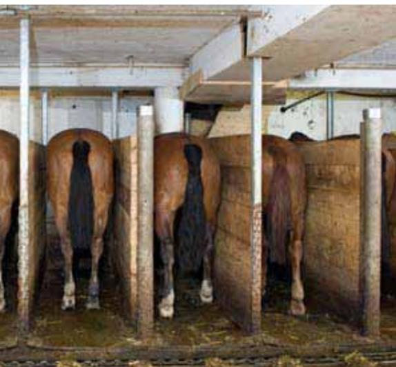
Die ehemaligen Ständer (oberes Bild), in denen die Pferde angebunden wurden, hat Gian Clalüna in Fressstände umgebaut (unten). Die Höhe der Boxenwände hat er reduziert, damit er die Tiere von einer benachbarten Box aus herausführen kann.
