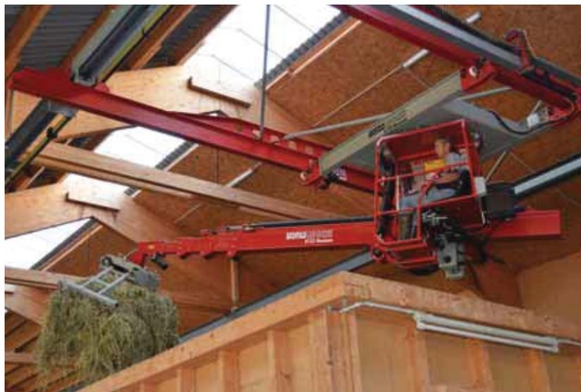
Die Greiferanlage garantiert eine rationelle Ein- und Auslagerung des Raufutters und des Strohs.
