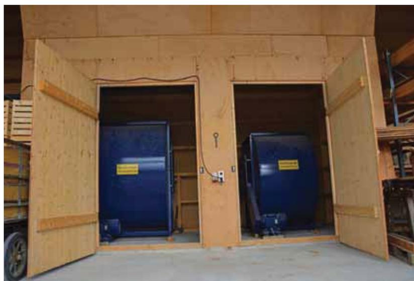
Die Lüfter saugen die unter dem Eternitdach erwärmte Luft ab und blasen sie in die beiden Futterlagerräume.
