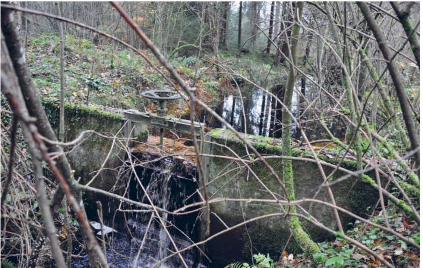
Das Stauwehr im ehemaligen Entwässerungskanal sorgt für einen gleichbleibend hohen Wasserspiegel.
