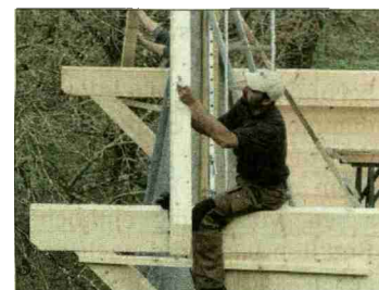
Das meiste am Bau entstand in Eigenleistung.
