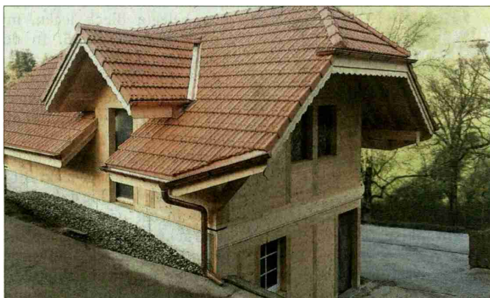
Im neu errichteten Gebäude wird ab Mitte April der Hofladen untergebracht sein. (Bilder: zvg)
