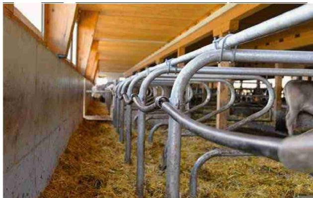
Der vordere Boxenausgang als Fluchtweg ist einer der zentralsten Aspekte eines Laufstalls für Hornkühe.
