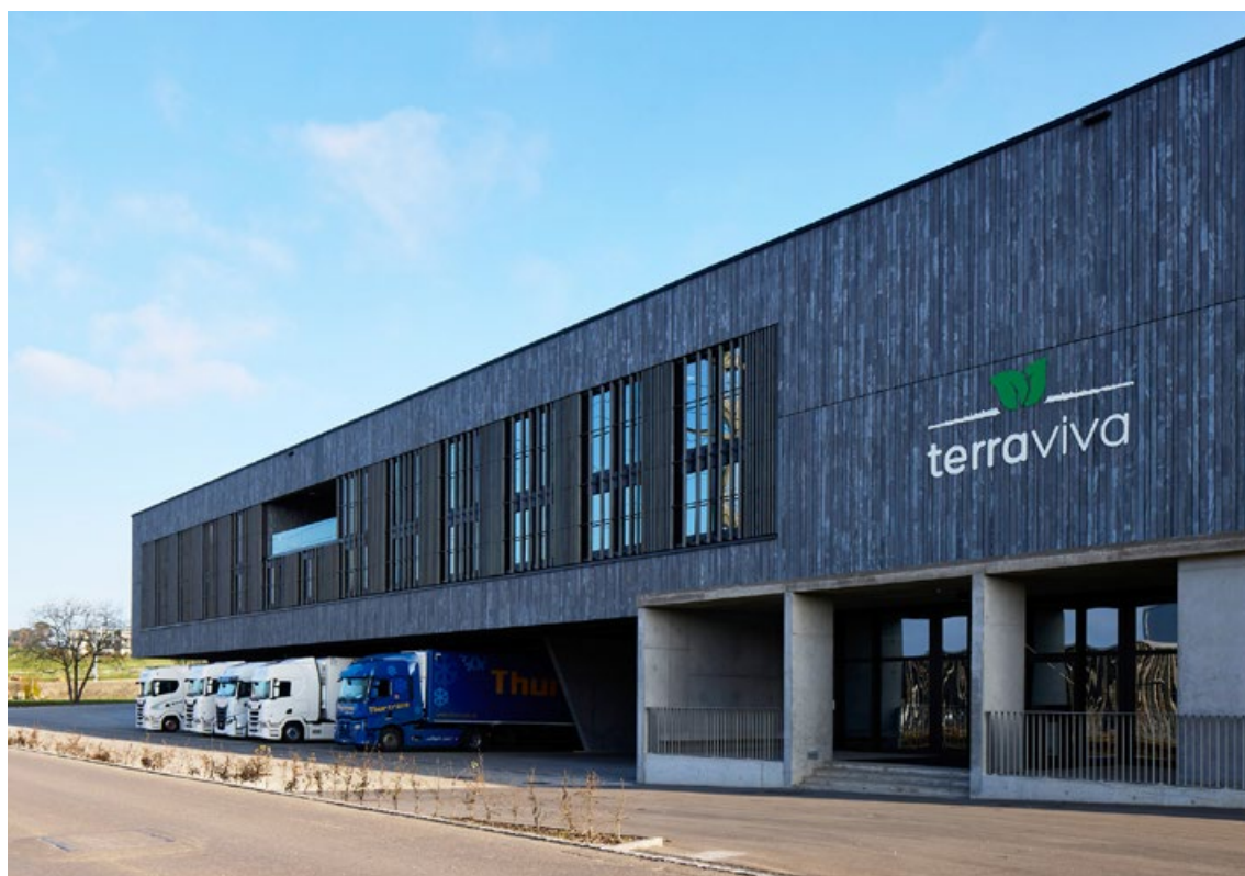
Heimisches Schaffen: Für die 3500 Quadratmeter Fassadenschalung wurde nur Schweizer Holz verwendet.
