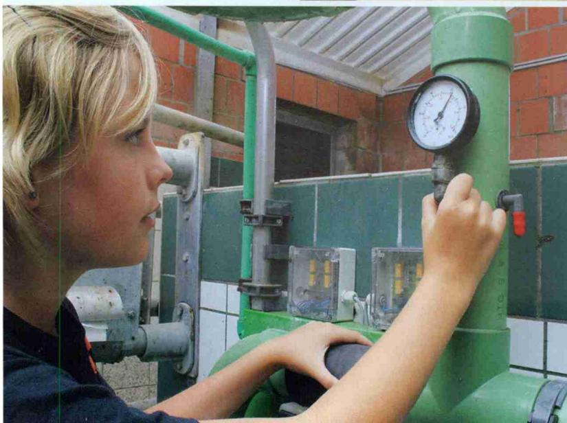
Die Stabilität des Vakuums sollte wie im Tal regelmässig kontrolliert werden.
