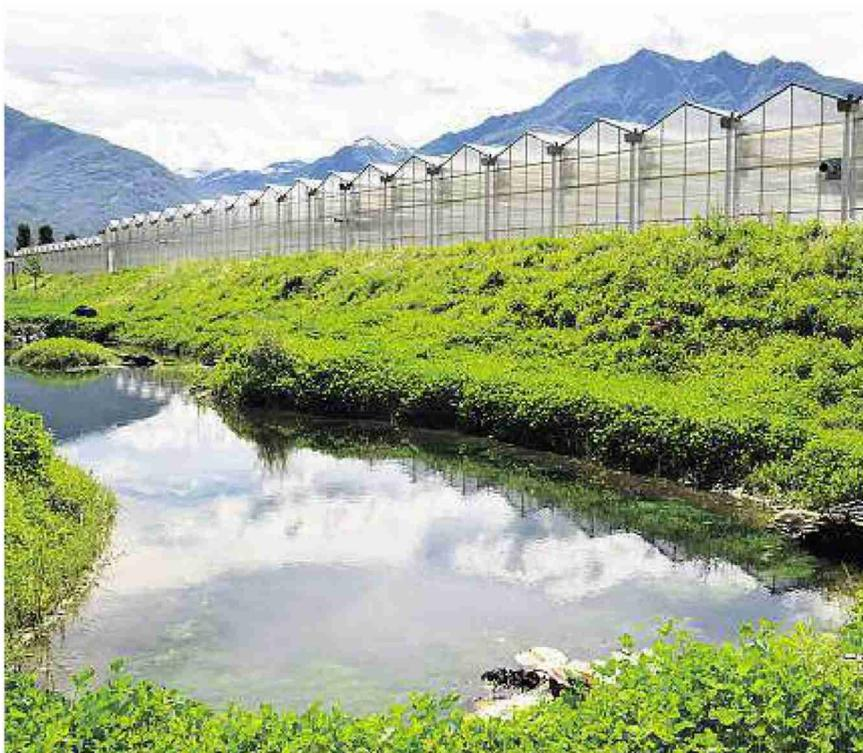
**Das Regenwasser** wird auf dem Glasdach des Gewächshauses gefasst, durch Rohre in die Versickerungsbecken und Biotope geleitet und gefiltert ins Gewächshaus zurückgepumpt.
