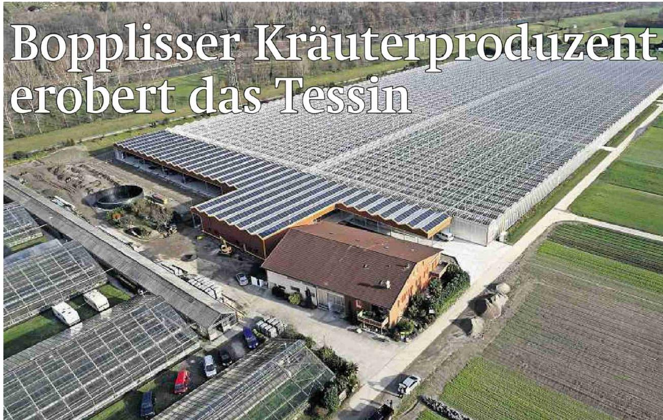
300 Meter lang und 130 Meter breit ist das Gewächshaus. Strom liefert eine Solaranlage, und auf eine Beheizung wird verzichtet.
