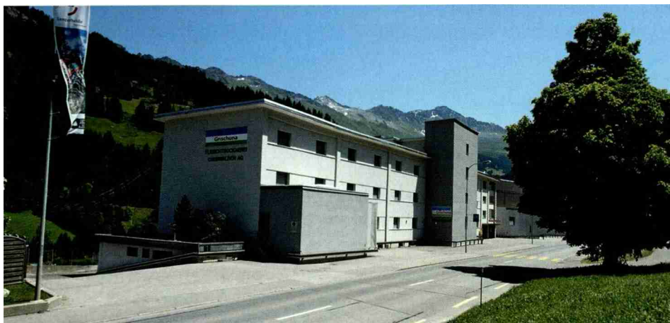
'n Churwalden wird «nur» noch getrocknet. Auch hier gab es bauliche und energetische Optimierungen.
