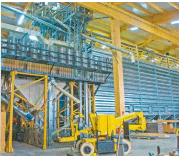
Die private Getreidesammelstelle hat der Landwirt selber geplant und 2015/2016 gebaut. 2017 hat er knapp 2000 Tonnen Bio-Getreide, -Ölsaaten und -Spezialkulturen von 50 Bauern angenommen. (Bilder: Doris Bigler)
