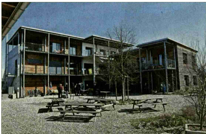
So sehen die zwei Betriebsgebäude auf dem Biohof Schüpferried aus. Der Hofsaal ist im 1. Stock des linken Gebäudes.
