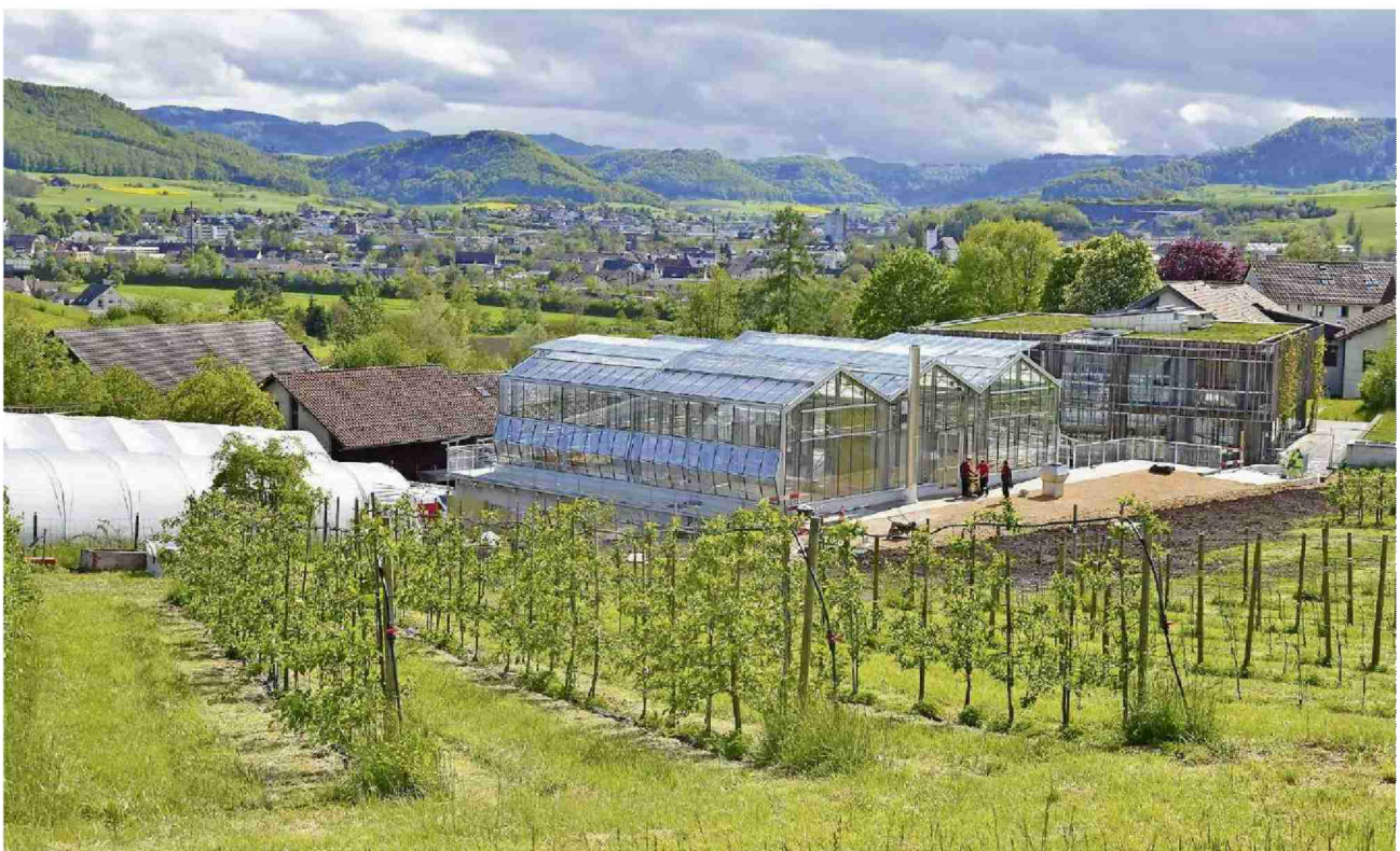
Mit dem neuen Gewächshaus ist die erste Bau-Etappe des Forschungscampus abgeschlossen.
